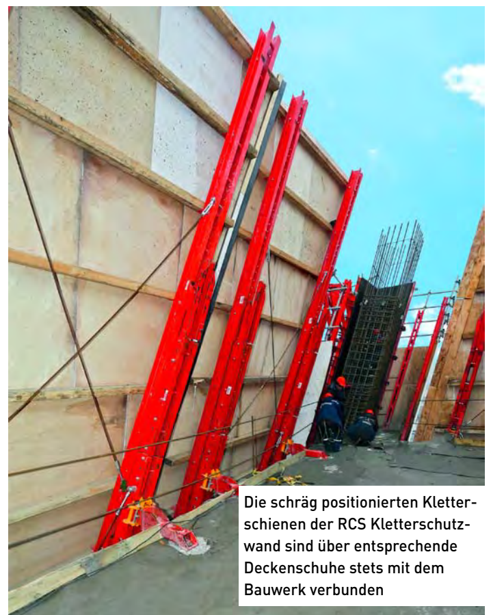
Selbst die Ausfahrbühnen kletterschienengeführt – und mithilfe der mobilen RCS Kletterhydraulik ohne Kranunterstützung
