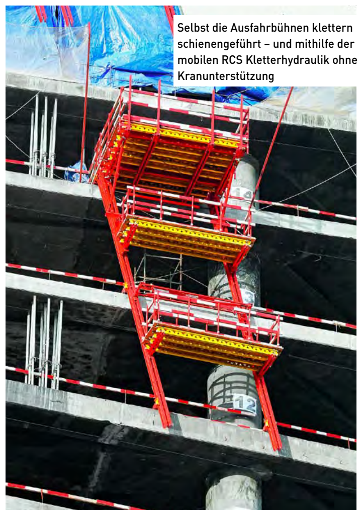
Die schräg positionierten Kletterschienen der RCS Kletterschutzwand sind über entsprechende Deckenschuhe stets mit dem Bauwerk verbunden
